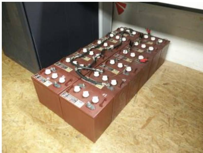
Das Medium für die Energiespeicherung ist bereits in Form von 12 6V Bleiakkus mit hoher Kapazität und großen möglichen Entladeströmen vorhanden.
