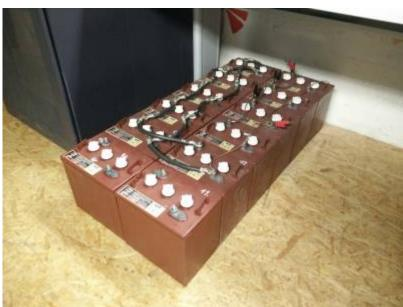
Das Medium für die Energiespeicherung ist bereits in Form von 12 6V Bleiakkus mit hoher Kapazität und großen möglichen Entladeströmen vorhanden.
